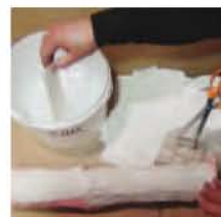
11 Travailler sur un seul côté pour pouvoir démouler
