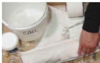
13 Faire la seconde partie de la chape en bandes plâtrées
